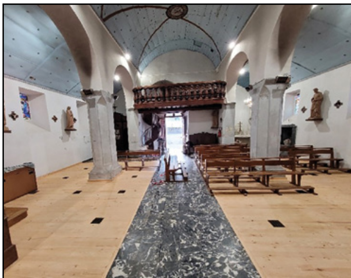
Ossen : Travaux à l'intérieur de l'église
