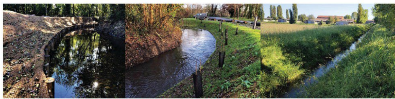
Le Moulin de Tiquette est situé sur la commune d'Arzon (53490) : Un tamis constitué de pieux bois et d'une clôture giratoire en châtaignier en pied de berge - la protection du talus à l'aide d'un géotextile coco biodégradable dans l'attente de sa végétalisation. Création d'une riberone composée de plantes héliophytes, le boitage du talus et la plantation d'essences arborées en haut de berge
