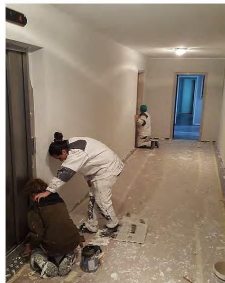
Chantier 1 er pas vers l'emploi OPH 65
