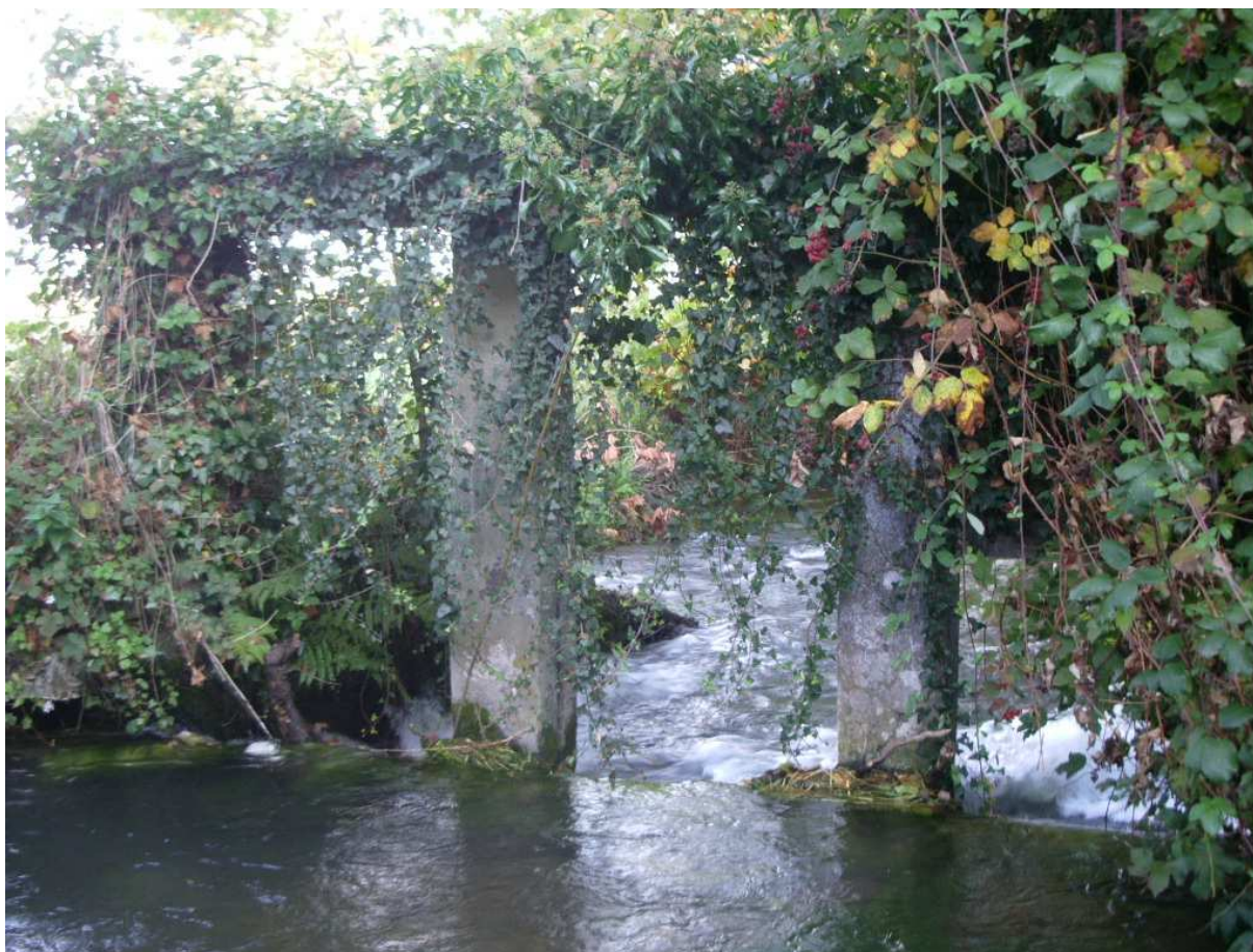
Un des anciens ouvrages faisant office de piège à embâcles
