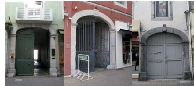
Exemples de portes principales en forme «d'anse de panier»
