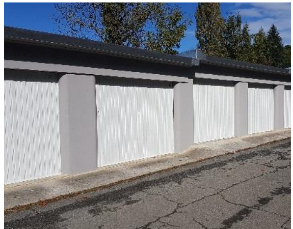
Chantier 1 er pas vers l'emploi Lannedarré, septembre 2019
