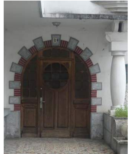
Porche d'entrée détail de colonne en béton moulé, porte à arc outrepassé, détail polychrome pierre et brique. Menuiserie en bois.
