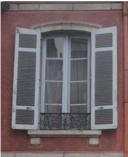
Fenêtre à encadrement en pierre surbaissé, appui sur consoles. Menuiserie en bois peint à grands vitrages, persiennes.
