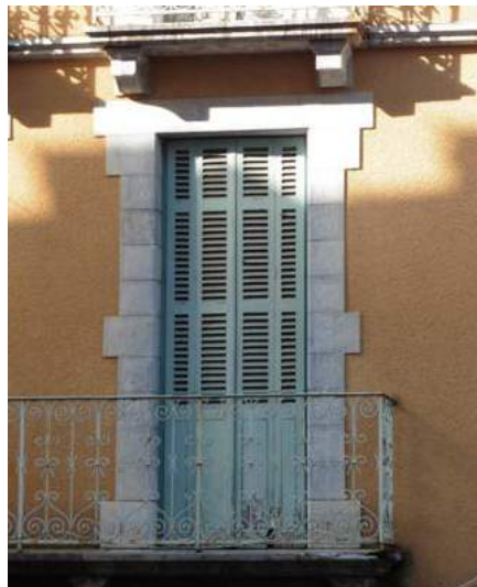
Porte-fenêtre encadrement de pierre de taille, volets en bois pliants persiennés. Ferronnerie du balcon.
