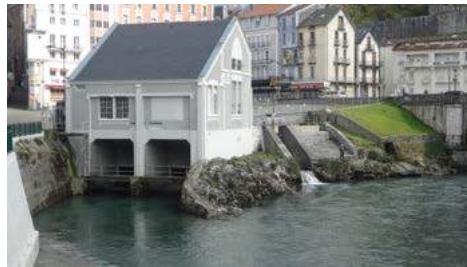
Centrale hydro-électrique de la Grotte, près du pont Saint-Michel
