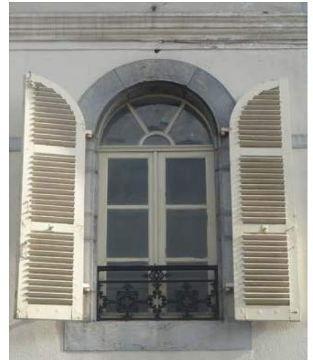
Fenêtre à imposte rayonnante, partition du vitrage à grands carreaux, contrevents en bois persiennés.
