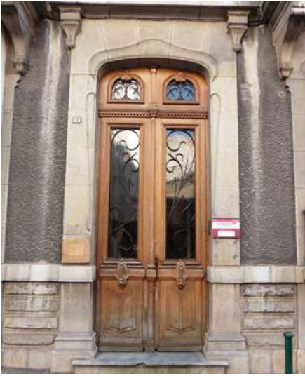
Encadrement en pierre inspiration Art Nouveau. Porte à vantail double, panneaux de bois sculptés et vitres, jour d'imposte.
