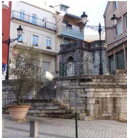
Les fontaines sur la place Marcadal,
