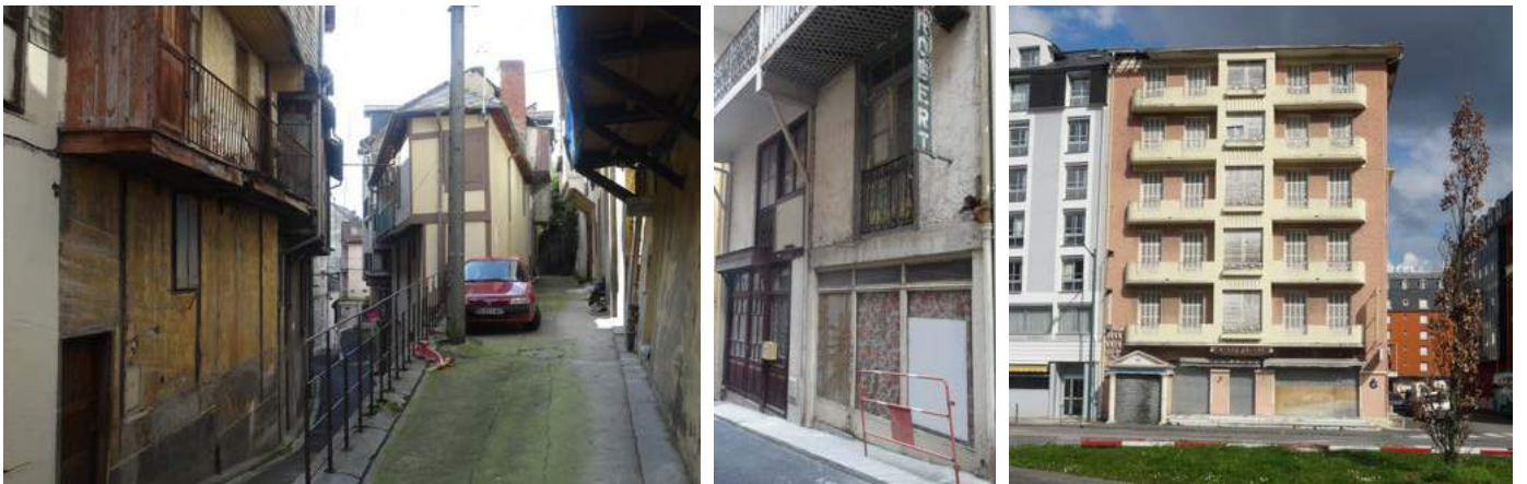
Petit bâti derrière le boulevard de la Grotte, rue des Cagots : mauvais état, mal logement, vacances ...
