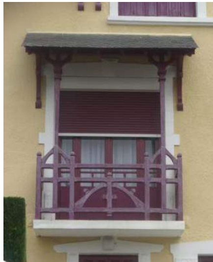
Détail du balcon protégé par un petit auvent supporté par les piliers et consoles en bois sculpté.
