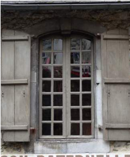
Fenêtre type XVIII e siècle, linéau incurvé, partition du vitrage à petits carreaux, contrevents en bois plein montés sur barres.
