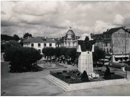
Place Peyramale avant 1956, en premier plan le monument aux Morts, à l'arrière l'hôtel des postes de Lacrampe remplacé en 1958 par l'hôtel des postes actuel. Source archives de Lourdes.
