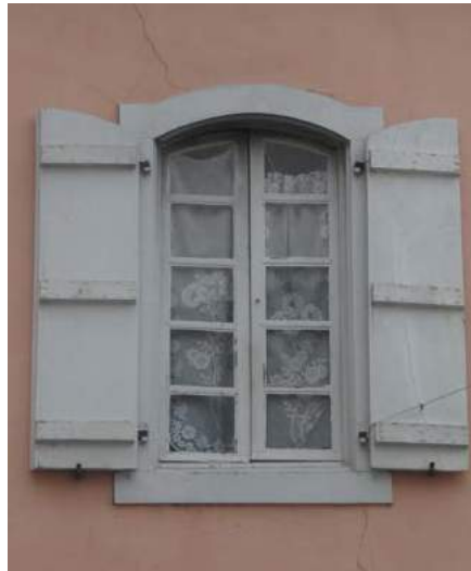
Fenêtre à linéau incurvé, en bois, partition du vitrage à petits carreaux, contrevents en bois plein montés sur barres.
