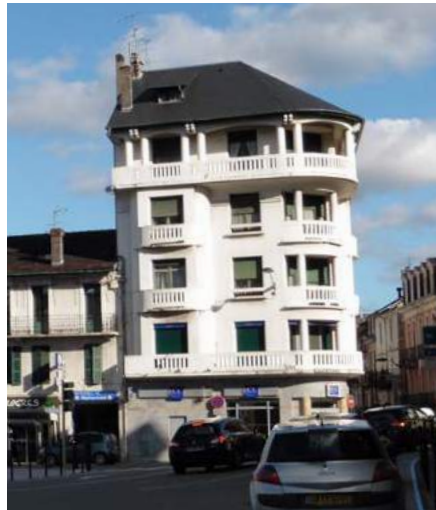
Bâti de la période contemporaine, béton banché ou en blocs, enduit ciment.
