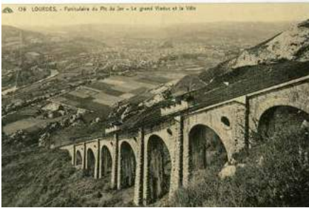
Funiculaire du Pic du Jer et son viaduc. ADHP
