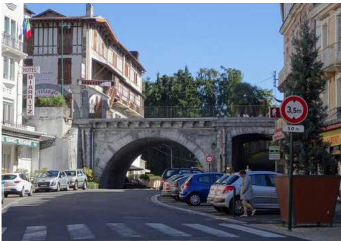
La chaussée Maransin et le pont sur le Lapacca vu de la Place Jeanne d'Arc.
