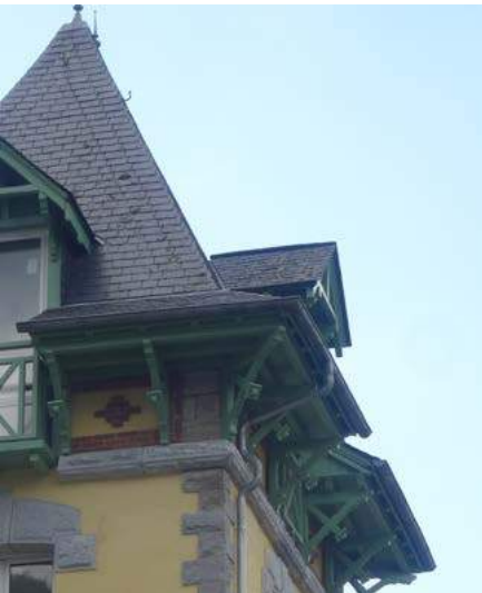
Détail de l'architecture du toit et du large débord : jeu de consoles en bois sculpté, bandeau en pierre, décor en brique...
