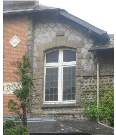
La baie s'inscrit sur un pan de mur au jeu de matériaux : galets, brique, pierre marbrière...couleur, texture....
