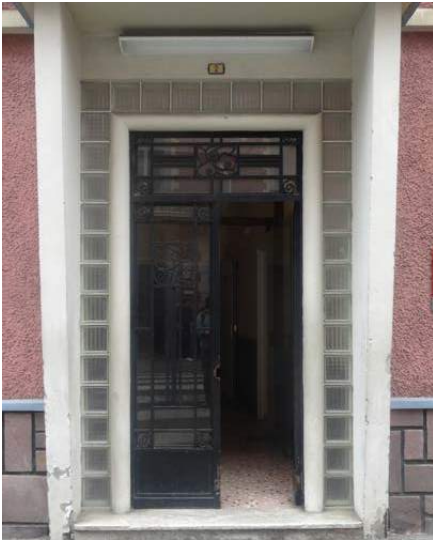
Porte métal et verre, encadrement carreaux de verre et béton moulé.
