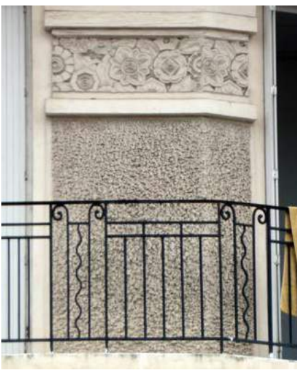
Façade Art-déco, détail des enduits à grain et lisérés lisses, frise en ciment moulé à motifs floraux.
