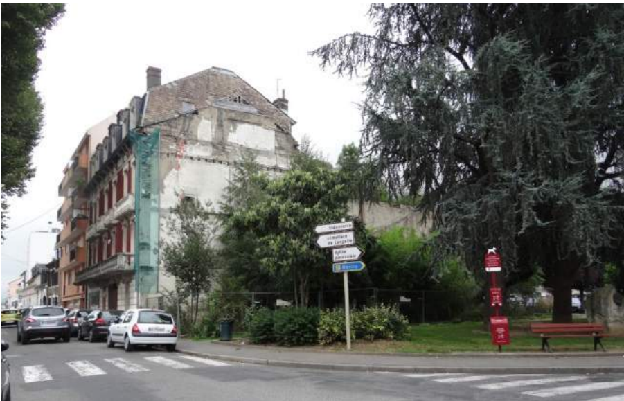
Bâties démolies et non reconstruits. L'espace libre est en rupture de continuité urbaine
