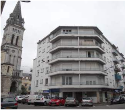
Concurrence esthétique des bâtiments contemporains sans recherche esthétique, et banalisation des paysages urbains
