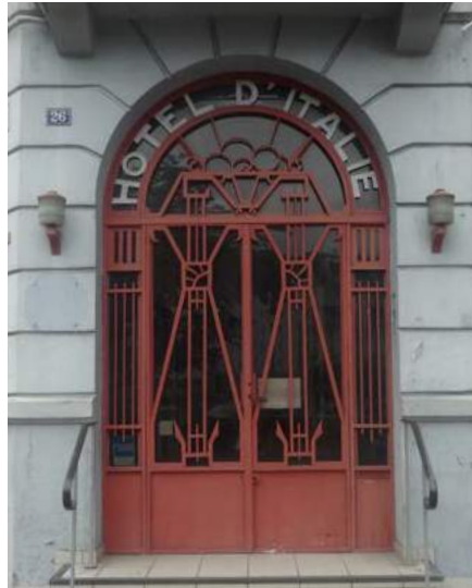
Porte métal et verre, détail du travail du métal.
