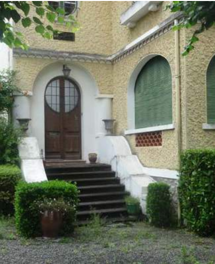
L'escalier d'accès à la villa depuis la cour jardinée.
