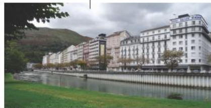
Le front bâti renouvelé sur l'avenue Peyramale.
