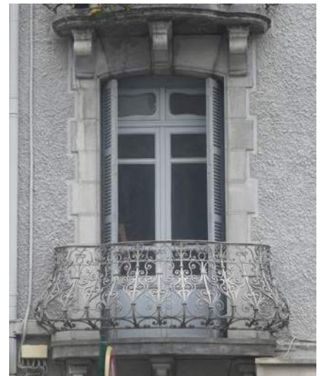
Porte fenêtre, volets en bois pliants persiennés, balcon à galbe en fer forgé reposant sur consoles de pierres.
