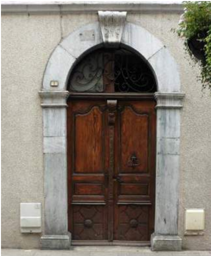
Encadrement en marbre, porte à vantail double, panneaux de bois sculptés, détail du couvre-joint. Jour d'imposte protégé par une ferronnerie.
