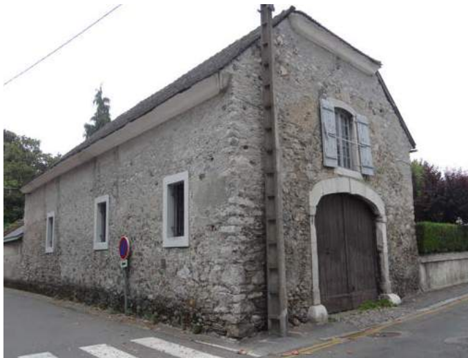
Ancienne grange sur la rue de Langelle
