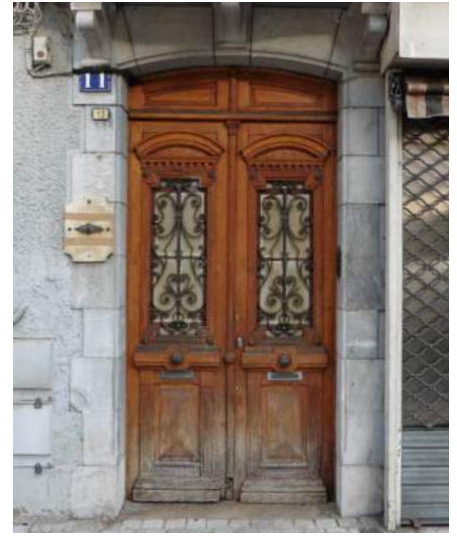
Encadrement arc surbaissé en pierre, porte à vantail double, panneaux de bois, grille de protection en fer forgé, serrurerie.
