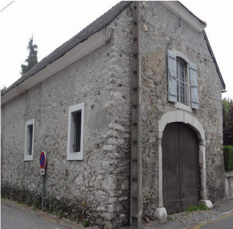
Construction traditionnelle, appareil tout venant (moellons calcaire, galets...) lié au mortier de chaux et sables locaux
