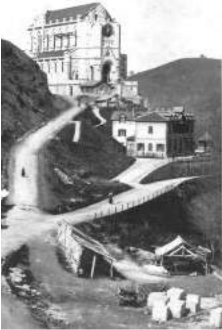
A gauche : Chapelle Notre Dame de Lourdes en construction. A droite, Hôtel Moderne, dans les sanctuaires.
