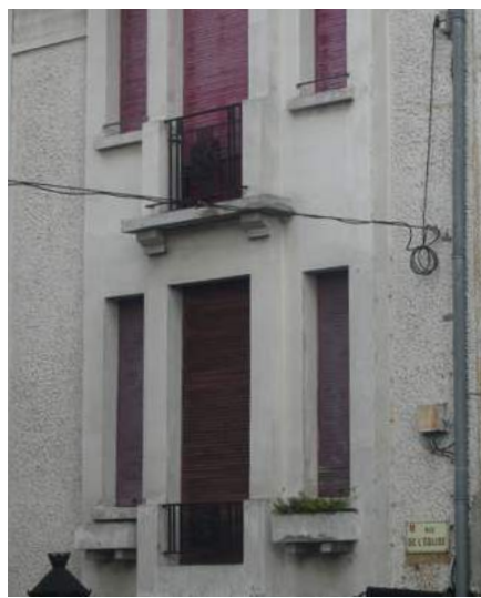
Façade Art-Déco, travées centrales en saillie sur fond lisse, modénature et jardinières en béton moulé, volets roulants en bois.
