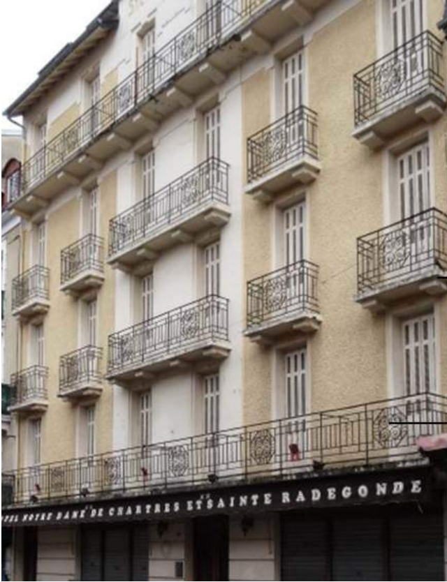
Balconnet sur console en béton
