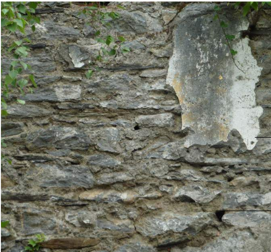
Enduit de protection
