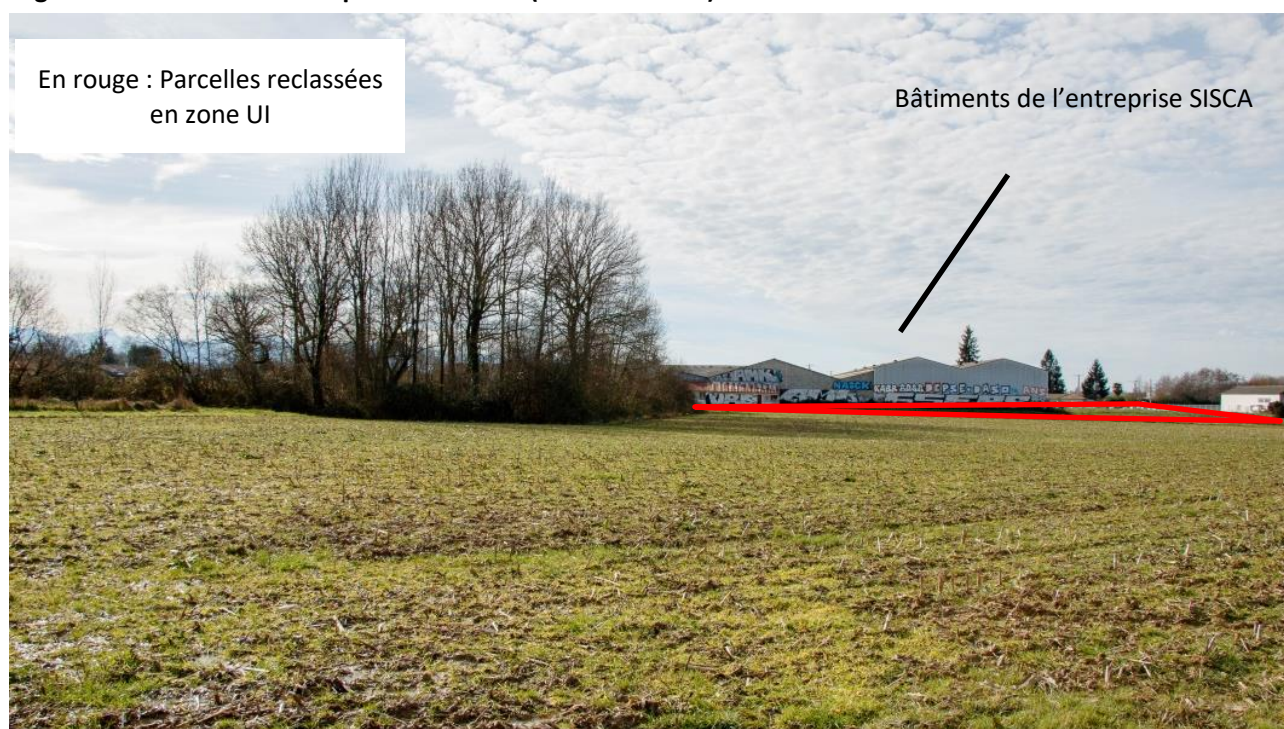
Figure 12 - Vue sur le site depuis le nord-est (autoroute A64)
