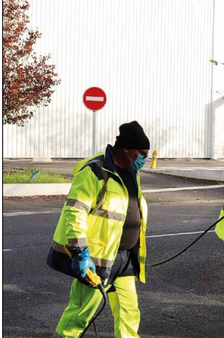
Intervention par les agents du service communautaire de l'Eau et Assainissement Gestion des eaux pluviales urbaines.
