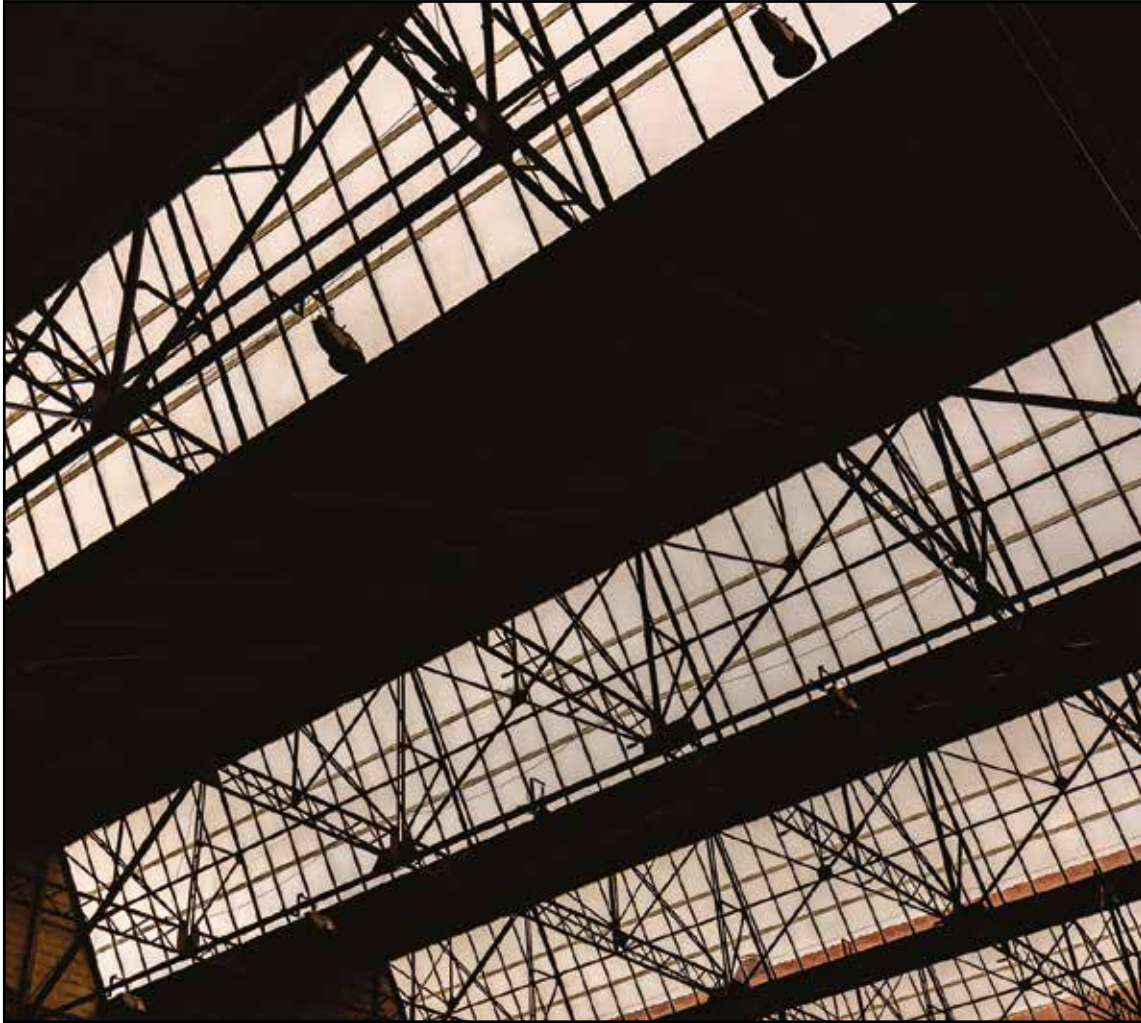
Vue depuis l'intérieur de la future Usine des Sports
