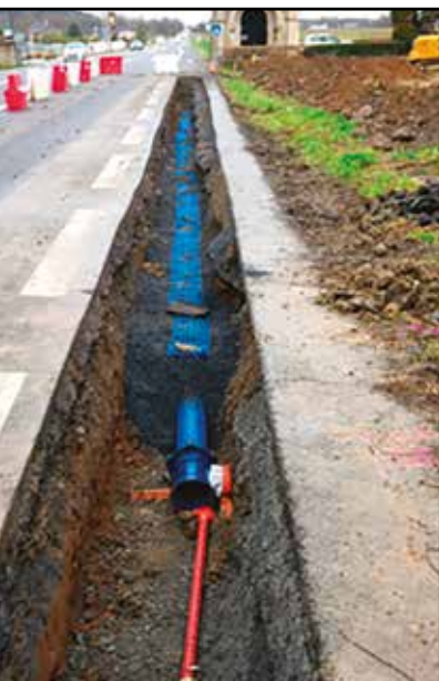
Travaux de déplacement de réseau d'eau Avenue des Pyrénées – ADÉ 27 000 € HT
