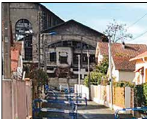
Travaux de renouvellement de réseau d'assainissement Allée des Mimosas – AUREILHAN 69 000 € HT
